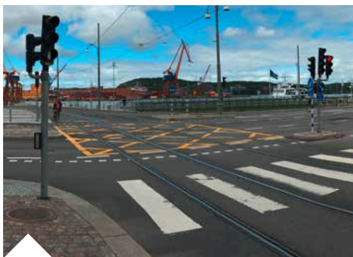
01: STRAILastic_SOK simplex mit Asphalt
